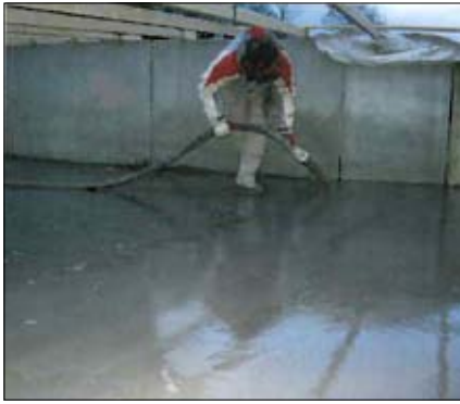
Figur 5. Kapaciteten för en slang är uppemot 15 m 3 /h och flera slangar kan användas samtidigt.
