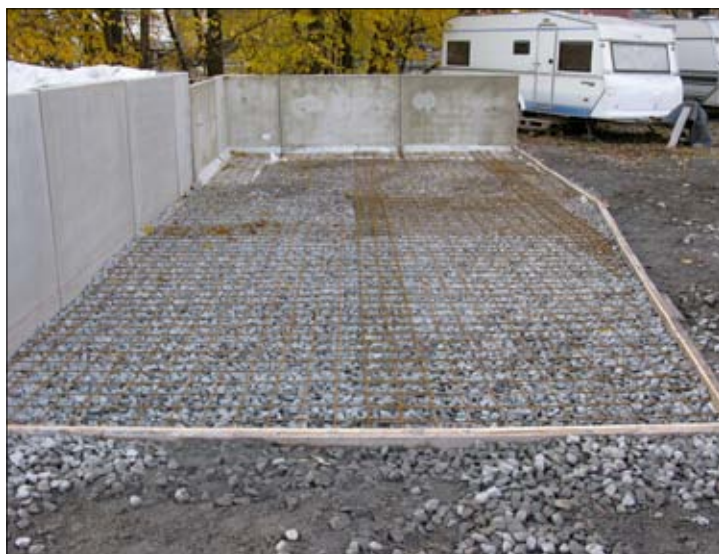
Figur 3. Det undre lagret sten är utlagt på en geo-textil. Armeringen läggs direkt på stenarna. Foto: Jonatan Paulsson-Tralla
