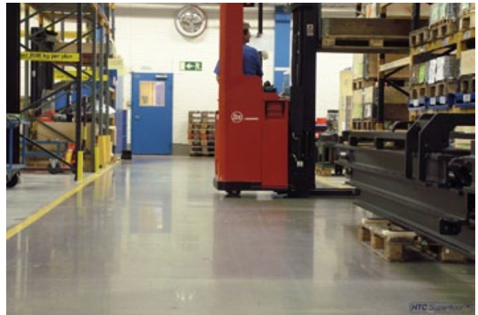
Polerad betong enligt HTC Superfloor™-konceptet i industriell miljö
