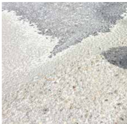
Die Reste eines 10 mm dicken Überzugs nach drei Bearbeitungsdurchgängen mit dem HTC Ravager™
